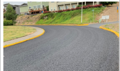
En la imagen: una aplicación de sello de niebla en la calle E Scenic Dr.-The Dalles.
