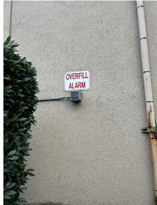
2: Overfill alarm
